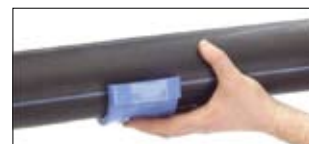
2. Puhasta toru, aseta sadula alumine osa toru alla
