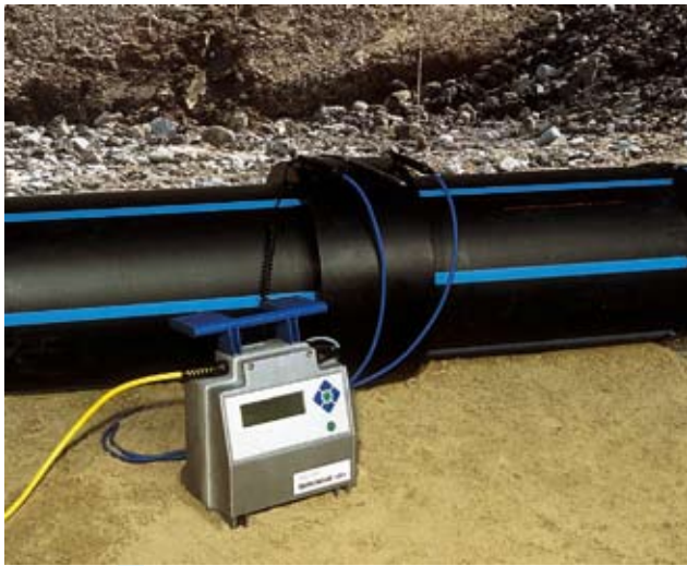
6. Keevitada sadul ja lasta jahtuda, seejärel puurimine peatorusse
