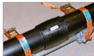
7. Valmis! Keevitustugede eemaldamine
