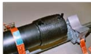
5. Keevitustugede paigaldamine
