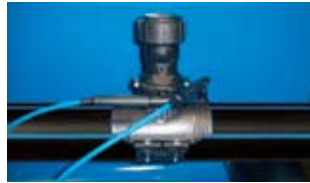
6. Keevitada sadul ja lasta jahtuda, seejärel puurimine peatorusse
