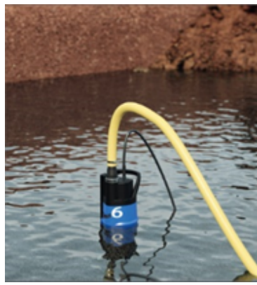
Järelevalve all pumpamiseks ehitusplatsidel
